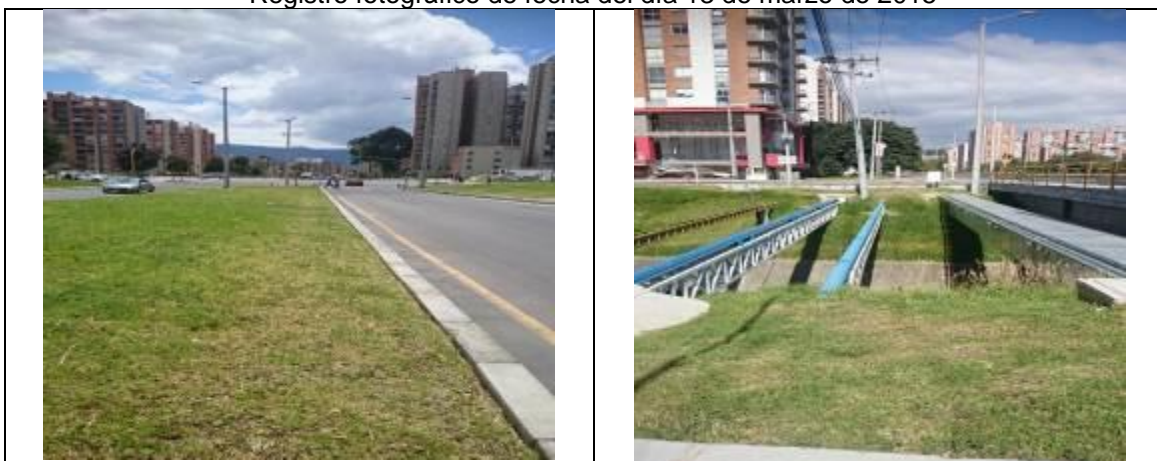
Cuadro N° 10 Contrato de obra IDU - 032 de 2011 Registro fotográfico de fecha del día 13 de marzo de 2015
