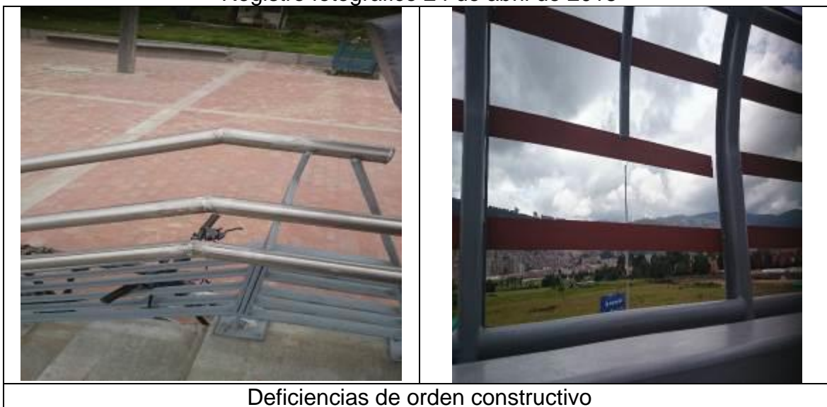
Cuadro N° 16 Contrato de obra idu-945-2013 Registro fotográfico 24 de abril de 2015
