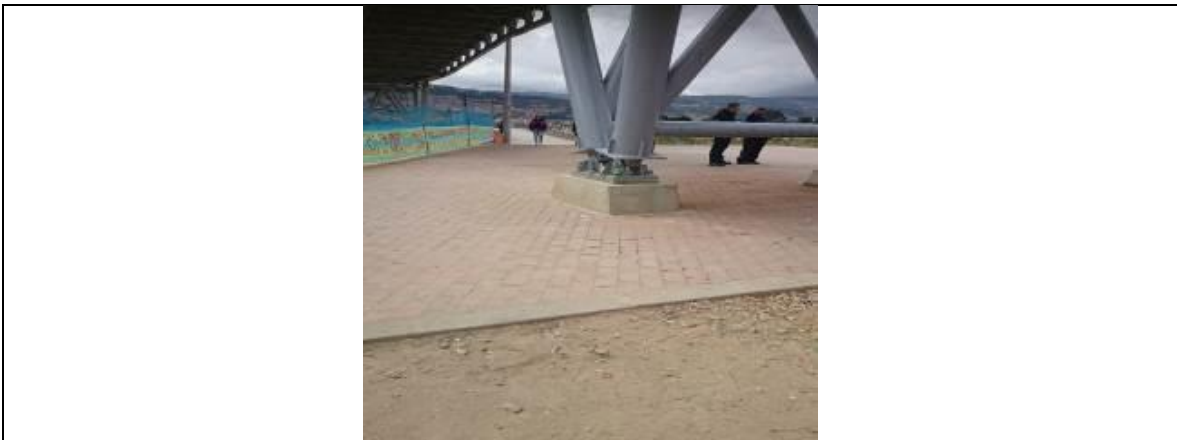
Zona pendiente por ejecutar a cargo del IDU
